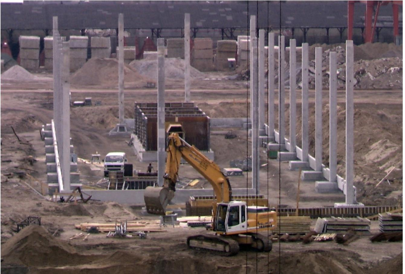
*Stahlbeton-Fertigstützen vom Entrinder-Zerhacker-Gebäude (EZ),
