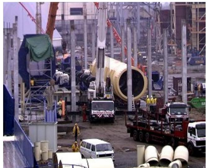
*Transport und Einbau der Entrindertrommel*
