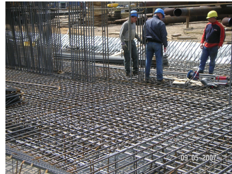
Fotos der Bewehrungsausführung Bodenplatte Austragskanal
