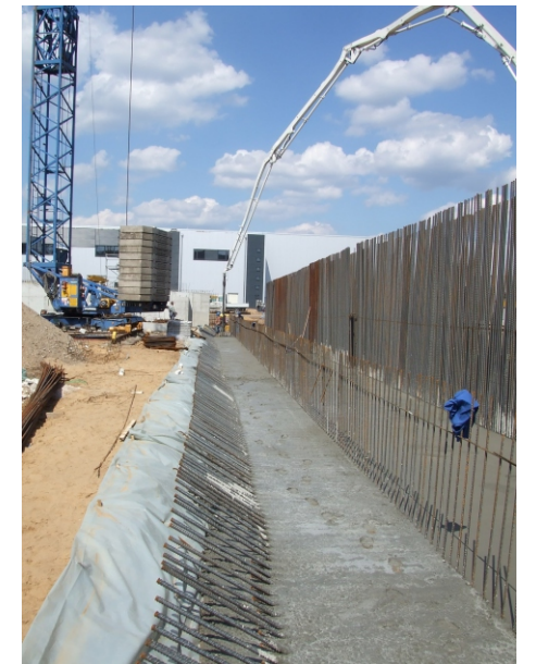
Fotos der Bewehrungsausführung Bodenplatte Austragskanal
