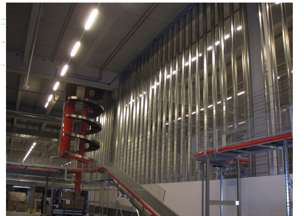
Halle A / LVL-Lager
