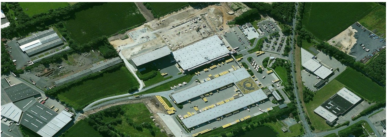
Luftaufnahme während der Bauausführung
