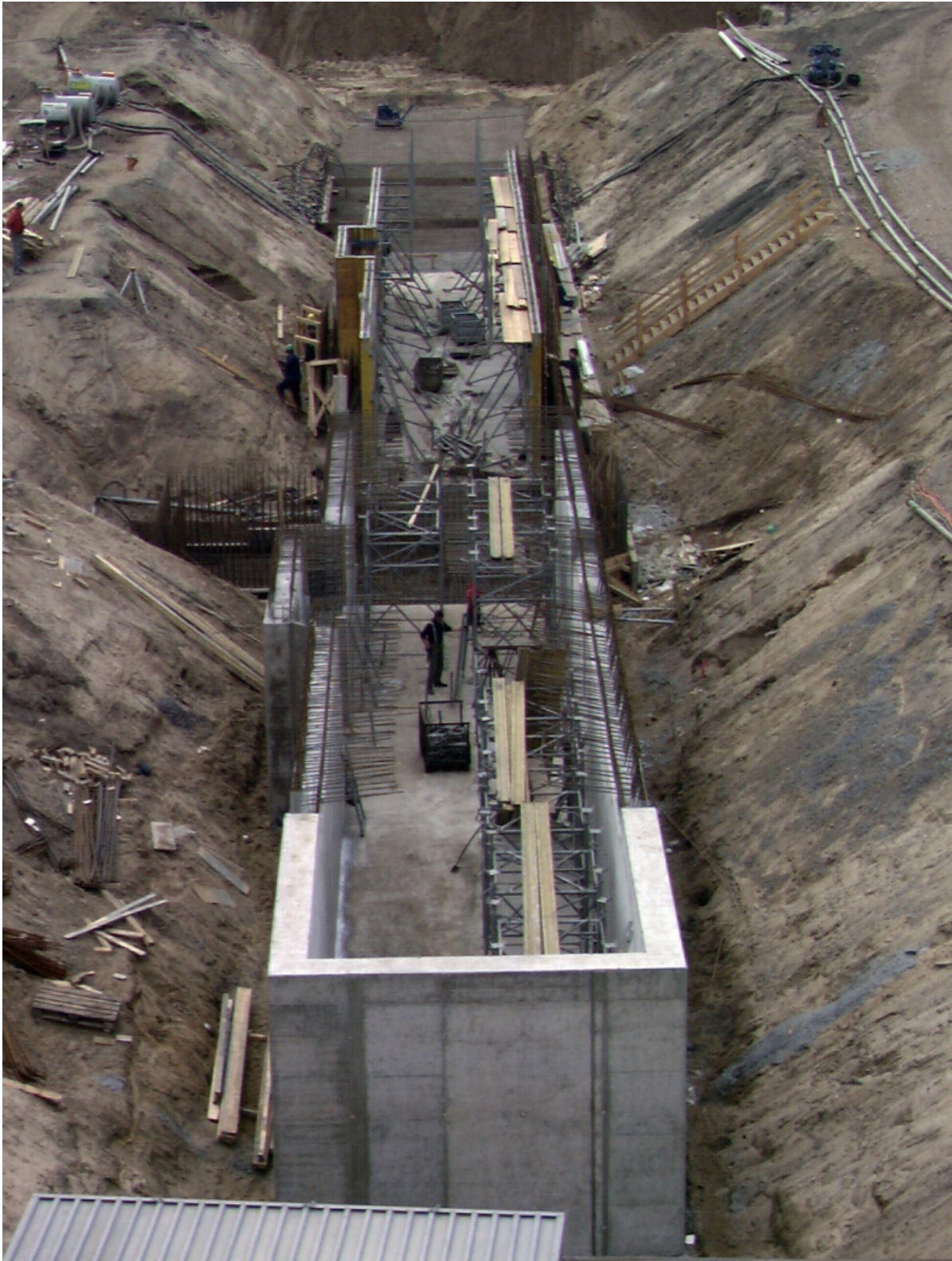
Kanal 1 (K1) während der Betonierarbeiten
