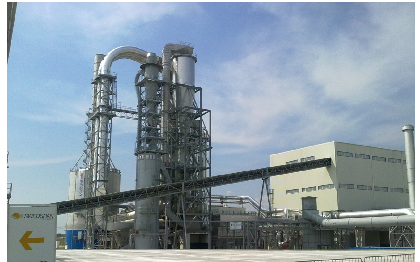
Foto Refinerhalle, Trocknerzyklone
