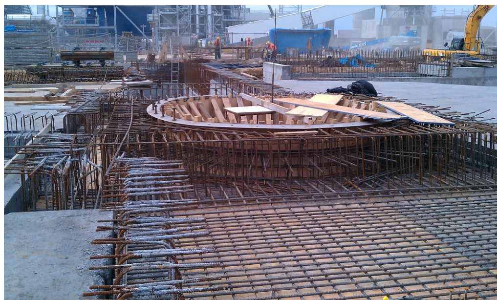
Bewehrung Silobodenplatte und Einlass Förderschnecke
