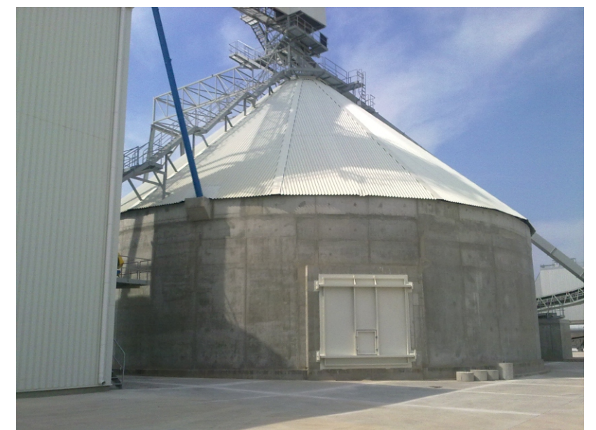
Silo nach Fertigstellung
