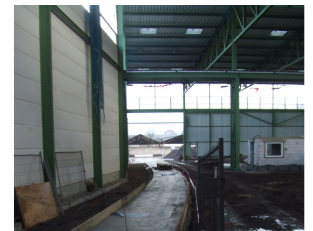
Fotos Wandverkleidung und Fassade
