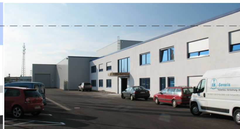
Foto während der Bauausführung
